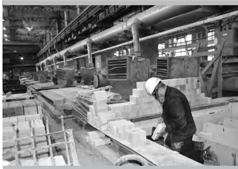
Строительство 18-го электролизёра
